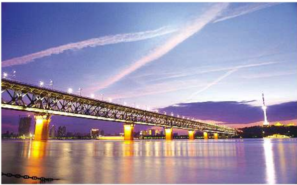
武汉长江大桥
